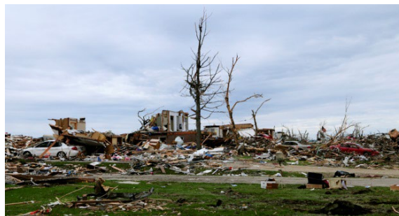
Figura 11. Escombros en Propiedad Privada
